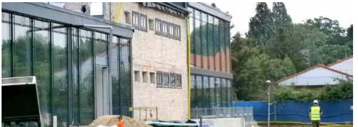
Na jednym z pawilonów zakończono już budowanie szklanej ściany
