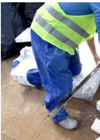
Osadzeni w stargardzkim Zakładzie Karnym szkolą się na pracowników ogólnobudowlanych
