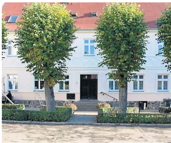
Urząd Miejski w Czaplinku oraz Miejsko-Gminny Ośrodek Pomocy Społecznej przechodzą dużą cyfrową modernizację.
