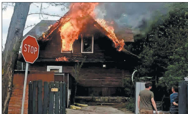
Ogień zniszczył dach i elewację drewnianego domu
