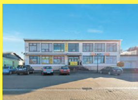
Dom handlowy w samym centrum Janowa Podlaskiego, 885 851 161
