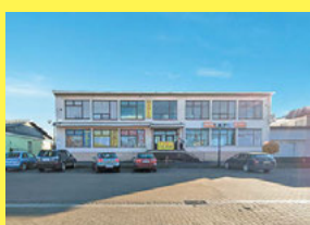
Dom handlowy w samym centrum Janowa Podlaskiego, 885 851 161
