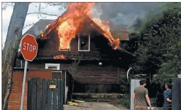
Ogień zniszczył dach i elewację drewnianego domu
