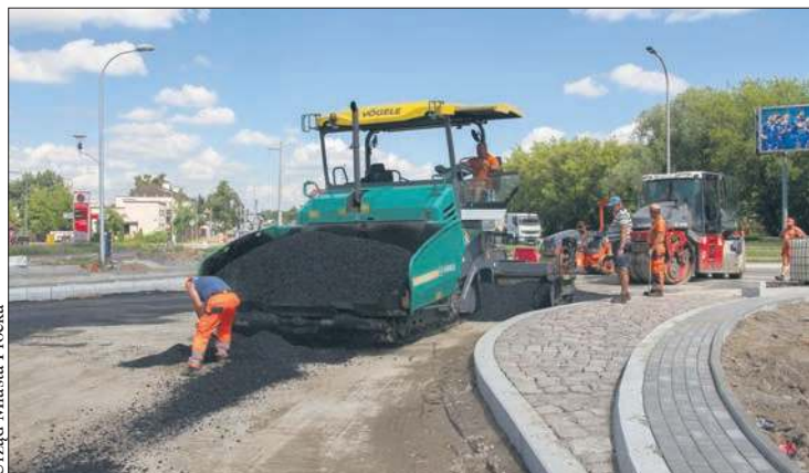
Prace na ul. Chopina
