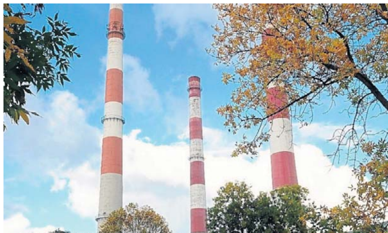
Rozbiórkę kominów na terenie dawnej elektrociepłowni EC-2 w Łodzi będzie prowadzić wyspecjalizowana firma
