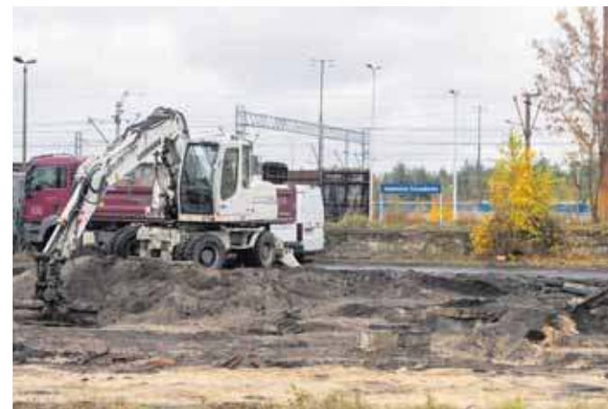
Rozpoczęła się budowa parkingu na 72 samochody w Szczakowej
