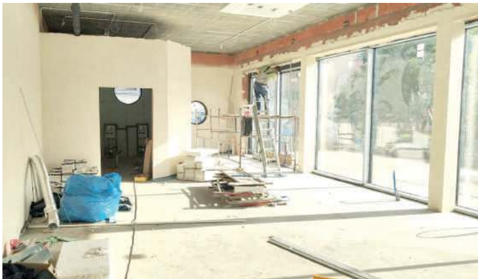
Obecnie trwają prace wykończeniowe. Wszystko ma być gotowe do 20 listopada. Dotrzymanie terminu jest bardzo ważne bowiem od tego zależy
