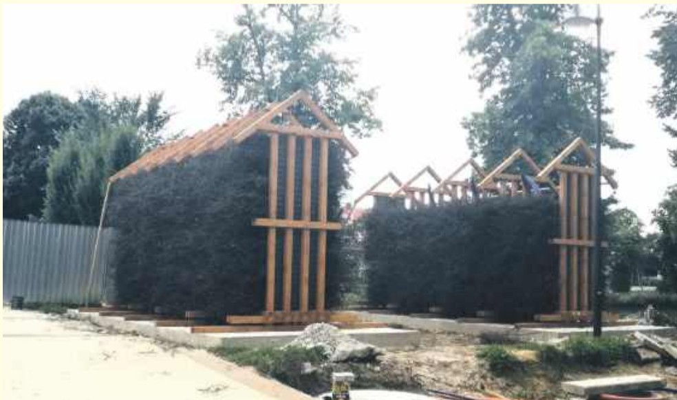
Tak budowano pierwsze mini tężnie w Trzebnicy
