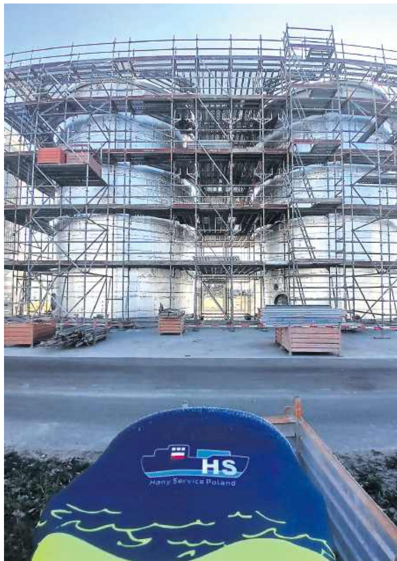
Izolacja tanków, Veendam
