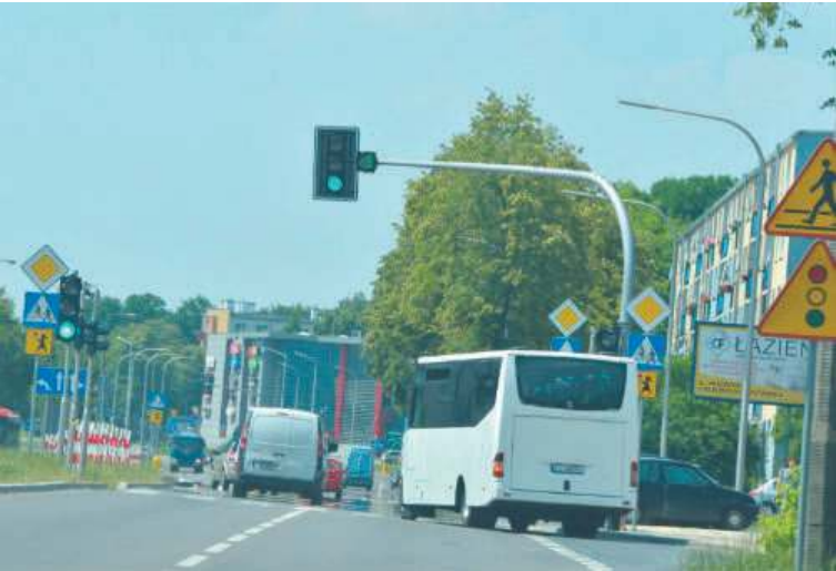
Sekundniki zainstalowano przy przejściu przez ul. Raclawicką w pobliżu skrzyżowania z ul. Kusocińskiego
