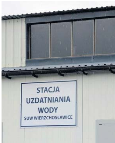
Rozbudowa stacji to bardzo ważna inwestycji w gminie
