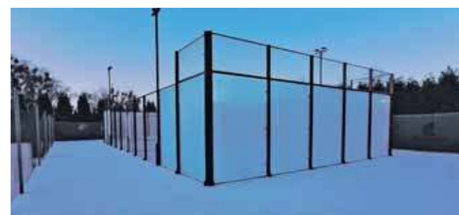
Pod koniec ubiegłego roku zakończyła się budowa nowego kortu do padla
