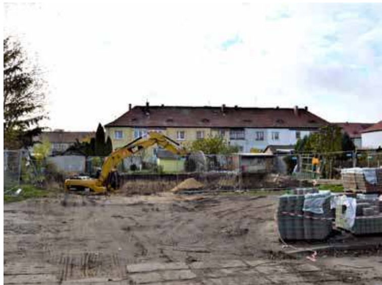
W tym miejscu powstanie trzykondygnacyjny budynek mieszkalny
