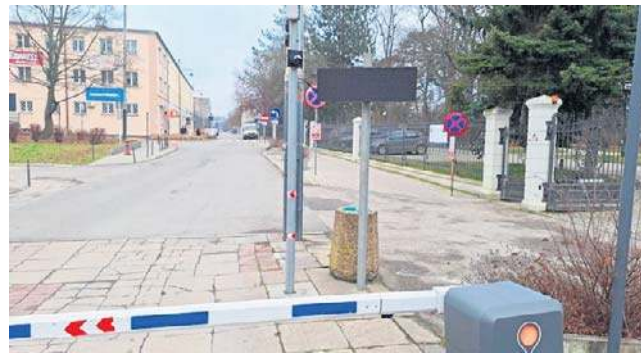
Nowy system parkingowy będzie działał podobnie jak ten zainstalowany pod halą sportową
