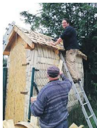
Piotr na drabinie podczas budowy ekosklepiku
