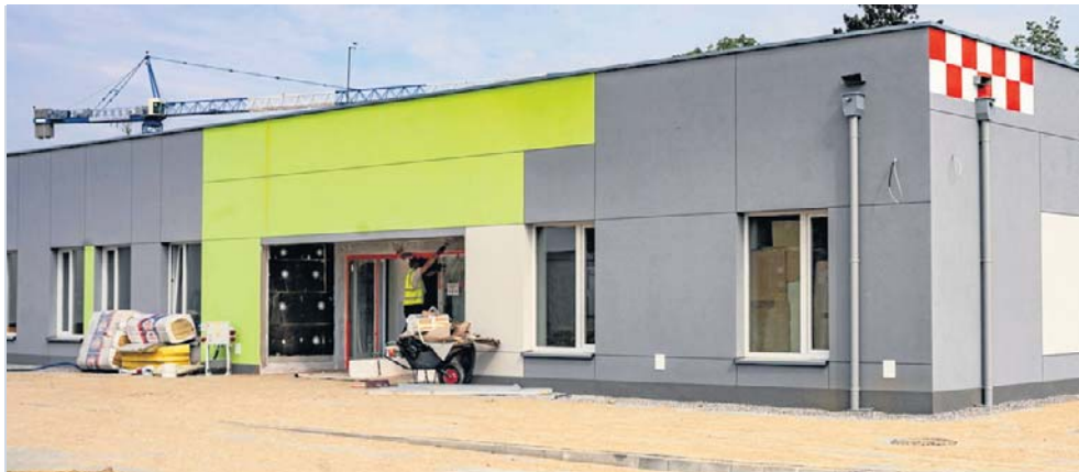
Prace przy budowie ZOL przebiegają terminowo
