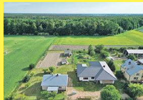
Parterowy dom do wykończenia w Woroczu, 885 851 172
