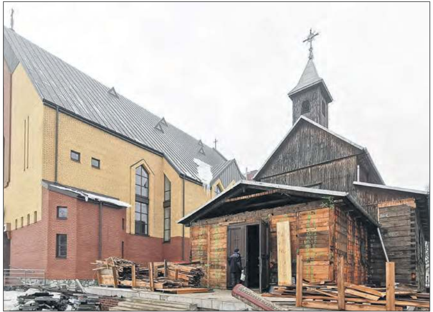
➤ Po oddaniu nowego budynku do użytku w 2019 roku, zabytkowy drewniany kościół przestał być wykorzystywany
