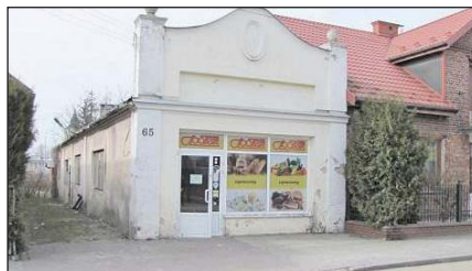
» Widok budynku handlowego ul. Nowa 65 (pkt. I.2 ogłoszenia)
