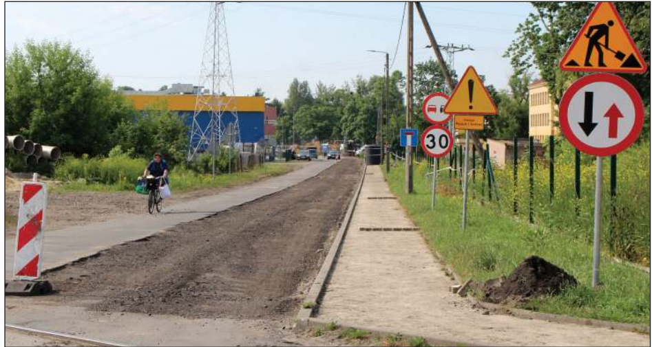
Ulica Towarowa jest zamknięta dla ruchu od strony ul. 15 PP Wilków. Na potrzeby inwestycji od strony liceum zostały wycięte drzewa oraz częściowo rozebrane ogrodzenie
