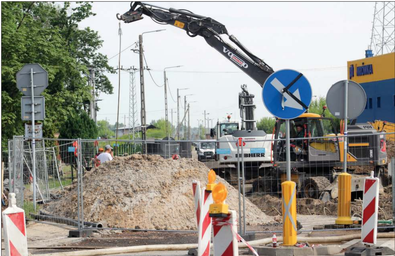
Na skrzyżowaniu obok marketu Lidl trwają zaawansowane prace związane z przebudową infrastruktury energetycznej oraz podziemnej
