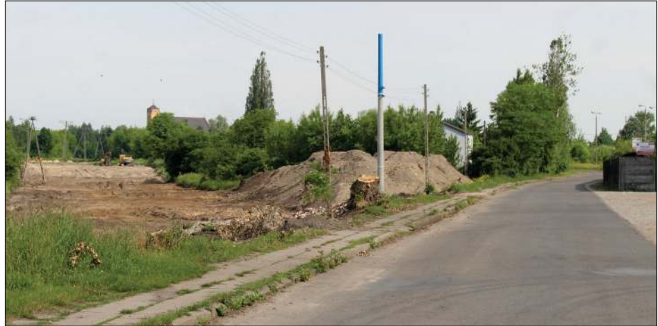
Na ul. Towarowej, na wysokości składu węgla obwodnica będzie odbijać w lewo i przecinać osiedle Żwica. Już teraz widać wykopy pod nową nawierzchnię
