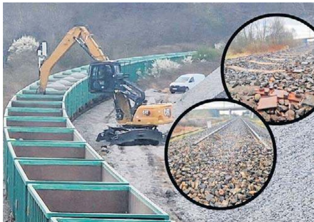
Zdzierane są tory, demontowane mosty. Prace mają się zakończyć we wrześniu.
