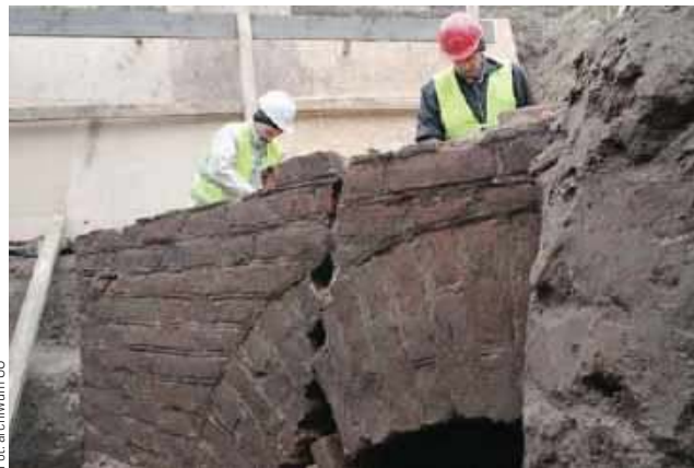
Początkowe prace przy rondeli
