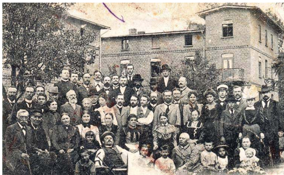
Kuracjusze nowomiejskiego „Marienbad” przed zabudowaniami zakładu
