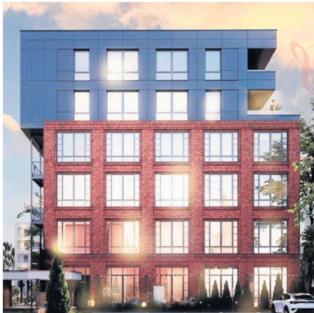
Częścią inwestycji Melody Park (ul. Pomorska 72/74) jest budynek Melody Loft (renowacja dawnej fabryki Rozenfeldów)
