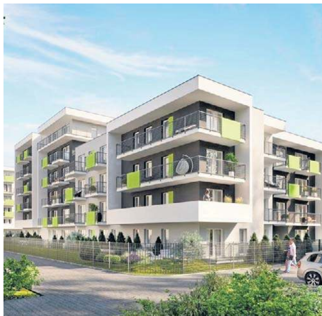
W szóstym etapie inwestycji Osiedle Nowe Złotno powstał budynek o kaskadowym układzie, a w nim 205 mieszkań
