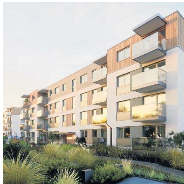
Osiedle Kwietne Łąki w Poddębicach utworzy łącznie pięć budynków, a w nich 125 mieszkań o pow. 39-64 mkw.
