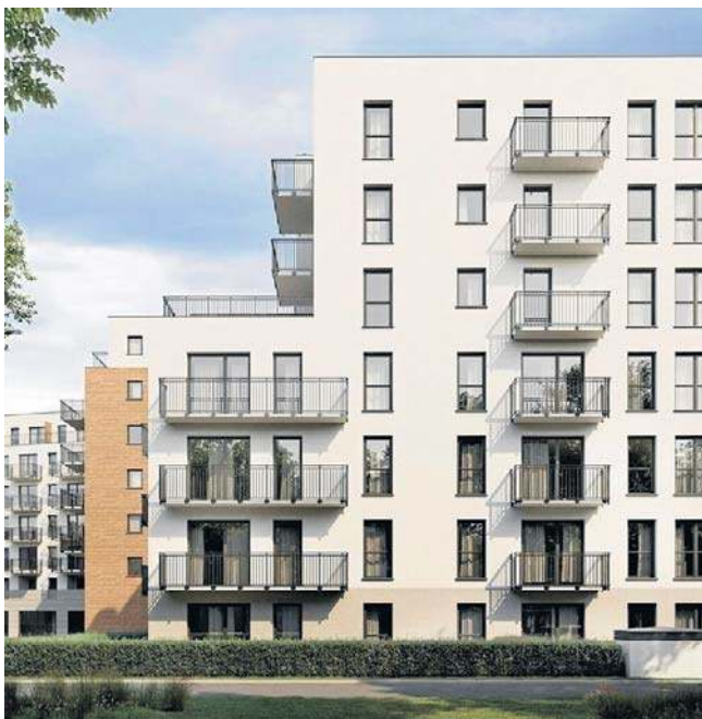
Murapol Agosto (trzy sześciopiętrowe budynki, 429 mieszkań) powstaje przy ul. 6 Sierpnia, tuż przy willi Leopolda Kindermanna
