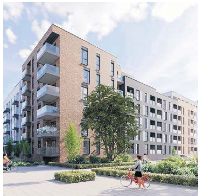
W IV etapie Osiedla Primo, w samym sercu Nowego Centrum Łodzi, powstaje pięciopiętrowy budynek z 326 mieszkaniami
