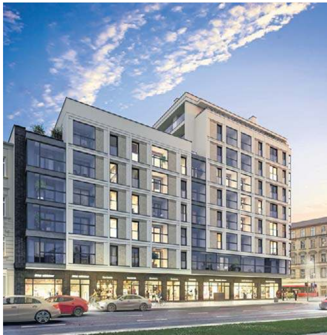
Trzeci etap Diasfery (róg al. Piłsudskiego i ul. Kilińskiego) tworzy budynek o kaskadowym układzie, a w nim 115 mieszkań
