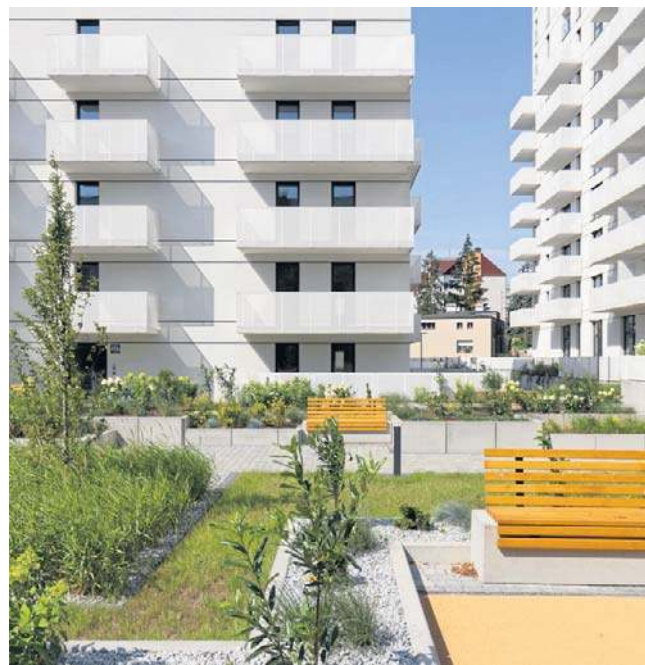
Nowa Retkinia przy ul. Maratońskiej 49 – kompleks czterech budynków z 321 mieszkaniami i urokliwą częścią wspólną
