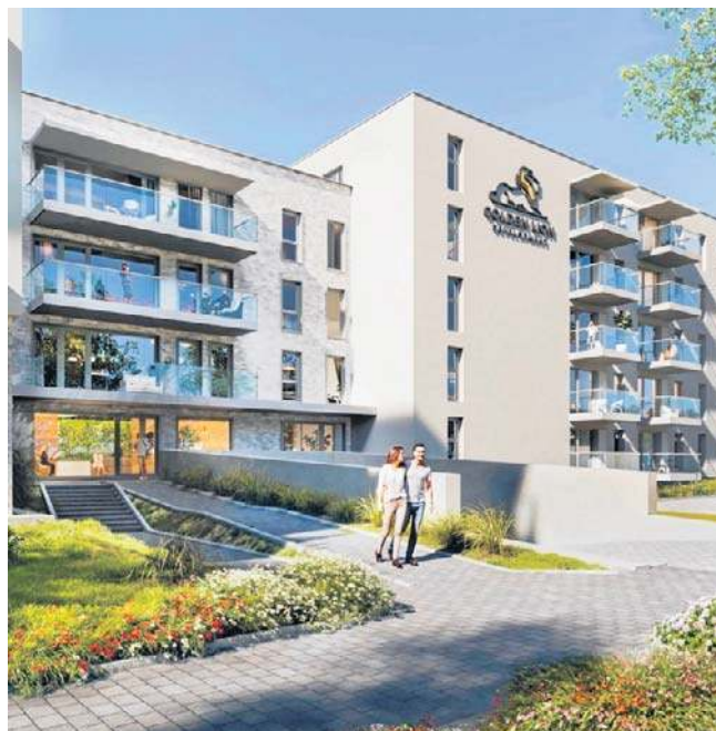
Enklawa Natury przy ul. Pienistej 80 – w pierwszej odsłonie powstaną dwa budynki, a w nich 103 apartamenty (42-108 mkw.)
