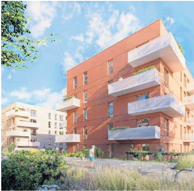
Och! Widzew (ul. Przybyszewskiego 292-300) to najnowsza propozycja Optimum Property – pięć budynków, 191 mieszkań
