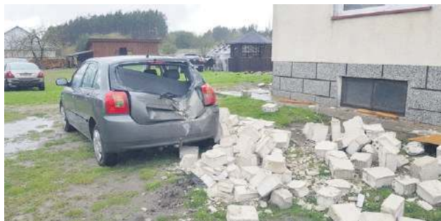
Spadające elementy uszkodziły auto.
