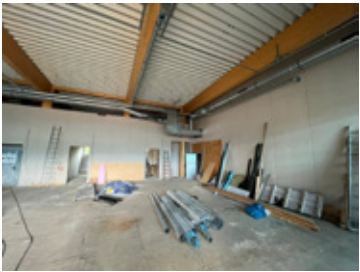
Budowa remizy strażackiej OSP z wykorzystaniem technologii przyjaznym dla środowiska.
