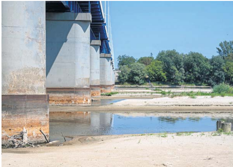
Wisła pod mostem w Dęblinie, stan z czwartku
