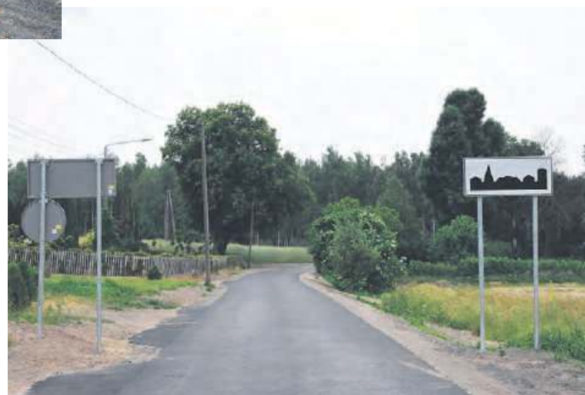
Asfaltem przez wieś.
