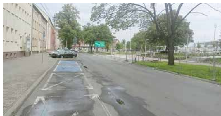
Ten odcinek drogi, biegnący przy Starostwie Powiatowym i Prokuraturze też ma być remontowany
