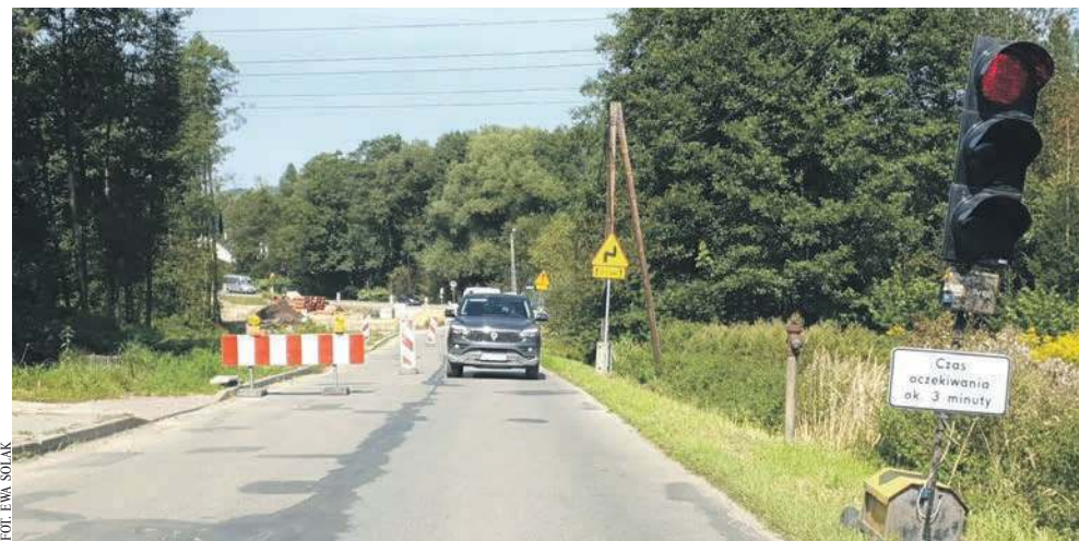
(E) Na modernizowanym zakręcie wprowadzono ruch wahadłowy
