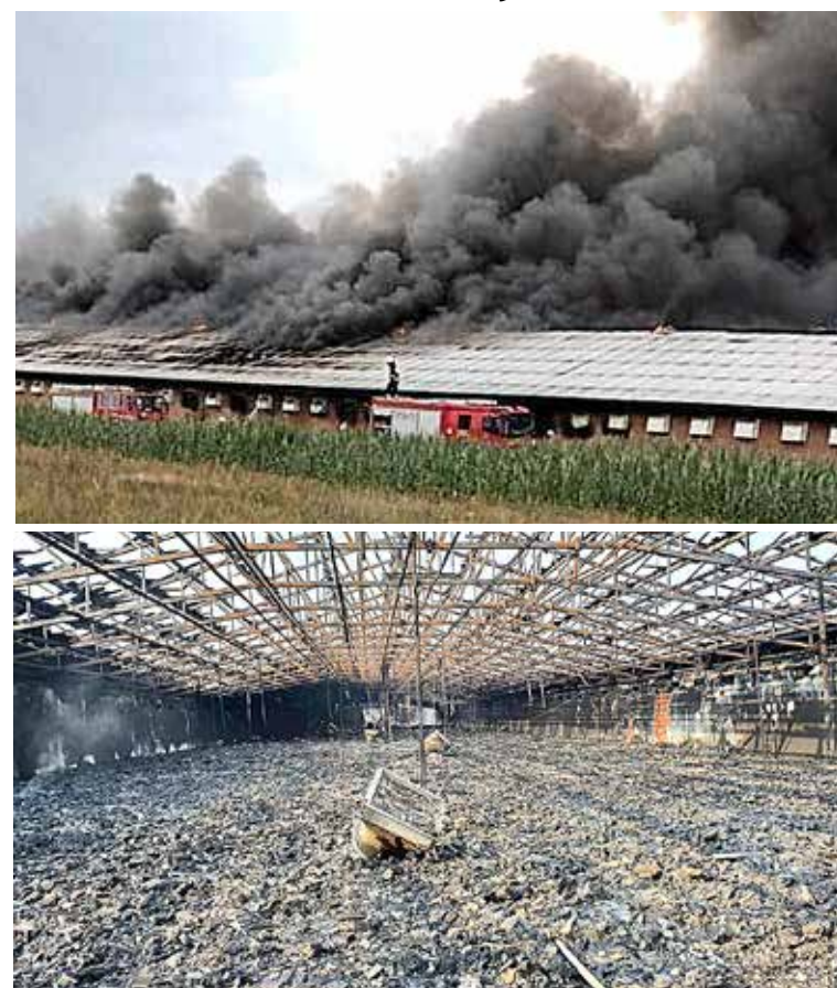
fot. arch. KP PSP w Łukowie
