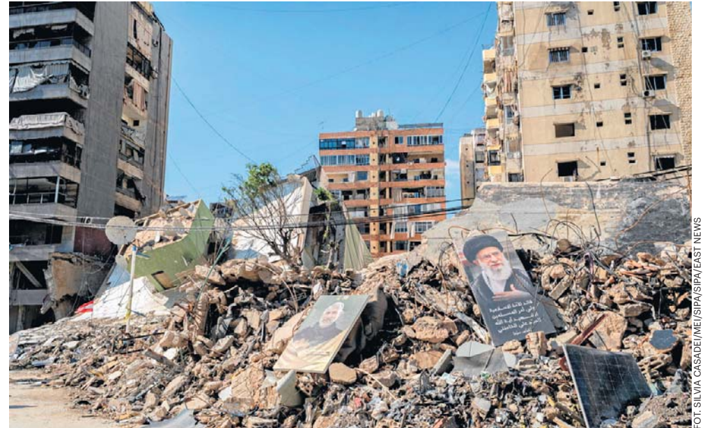
Zniszczone budynki na południowych przedmieściach Bejrutu. Tysiące mieszkańców po atakach trwających od marca zostało zmuszonych do opuszczenia swoich domów
