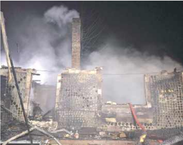
Murowano-drewniana altana spłonęła doszczętnie
