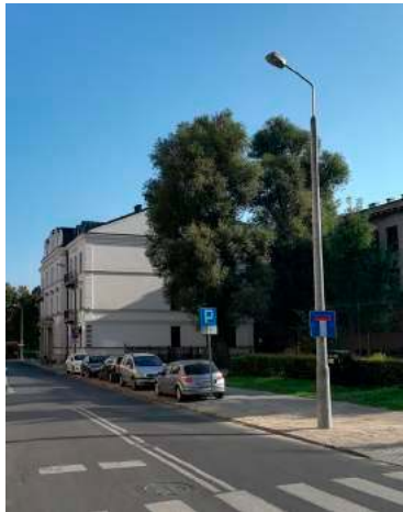
Zniszczone i straszące przechodniów latarnie na ulicy Niecałej zostały wymienione
