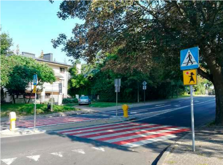
Przy SP nr 34 na środku jezdni powstała dodatkowa wypseka otoczona tzw. pasami bezpieczeństwa, tradycyjna „zebra” została przemalowana na lepiej widoczną białą-czerwoną
