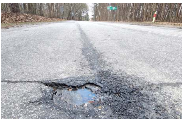
Tak wygląda fragment drogi wojewódzkiej 743 pomiędzy Górą Puławską a Sadłowicami. Za jakiś czas mieszkańcy pozbędą się takich widoków, bo w planach jest przebudowa tego odcinka
