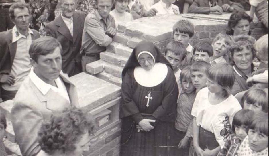
Dzieci od „0” do VIII klasy pomagały w donoszeniu cegieł, porządkowaniu terenu. Starsi pracowali przy wykopach, betoniarce, rozładunku i pomocy przy murowaniu ścian. W połowie czerwca 1980 r. odbyła się uroczystość wmurowania kamienia węgielnego ofiarowanego przez Jana Pawła II
