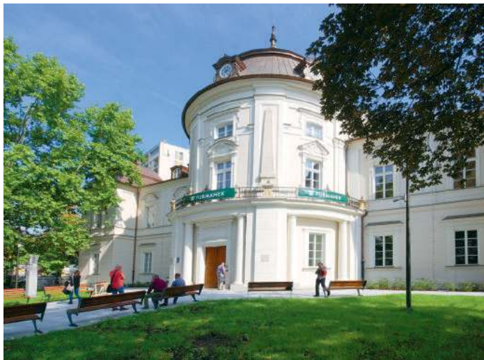
Pałac Przebendowskich/Radziwiłłów po renowacji.
