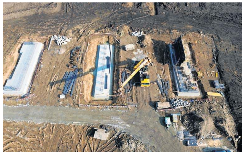
Tu rozpocznie się kolejny fragment najdłuższej drogi ekspresowej w Polsce. Pod samym Wrocławiem powstaje nowy węzeł
