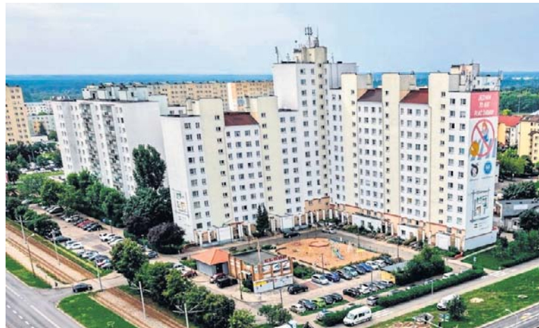
Spółka PGE Toruń dostarcza ciepło między innymi do budynków na osiedlu „Na Skarpie”
