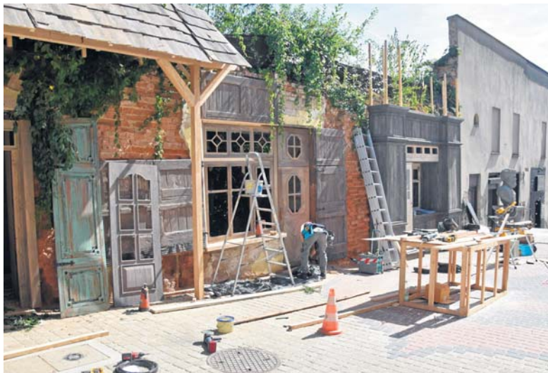
Tarnów. Na Wielkich Schodach i Tarasie trwa montaż scenografii do zdjęć nowej produkcji Netflixu. Pozostałości spalonej kilkanaście lat temu kamienicy zyskują nową zabudowę
