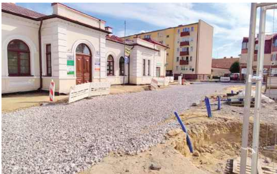
W związku z prowadzonymi pracami zostały zamknięte odcinki: ul. Czerwonego Krzyża fragment ul. Kościelnej wraz ze skrzyżowaniami z ul. Staropijarską i Nowopijarską
