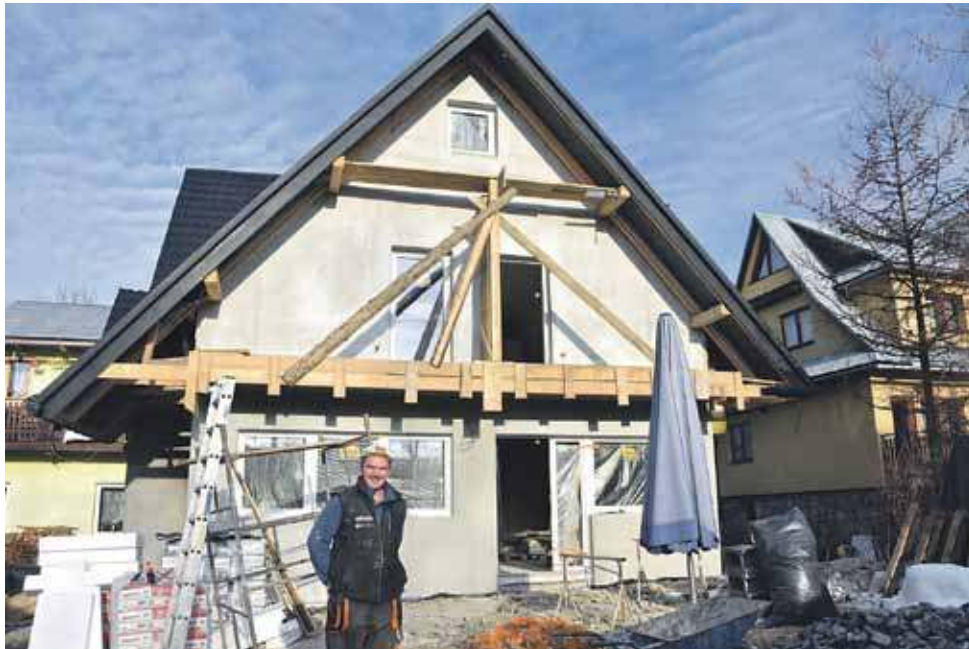
Dom rodziny Świdrów już stoi, na wykończenie i urządzenie budynku potrzeba jeszcze sporo pieniędzy. Na zdjęciu szczęśliwa głowa rodziny - Bartłoj Świder, oderwany na chwilę od pracy.
