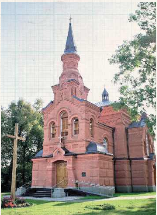
W Radczu, gdzie parafia unicka istniała wcześniej przez około 200 lat, postanowiono o budowie nowej cerkwi. Twórcą projektu był sam Wiktor Syczugow, jeden z najbardziej wziętych architektów w guberni. Oryginalnie fronton był bogaty w detale, które z czasem uległy zatarciu. Mimo nakładów do parafii przysłało tylko kilkanaście rodzin. Obecnie świątynia należy do parafii katolickiej pw. św. Mikołaja
