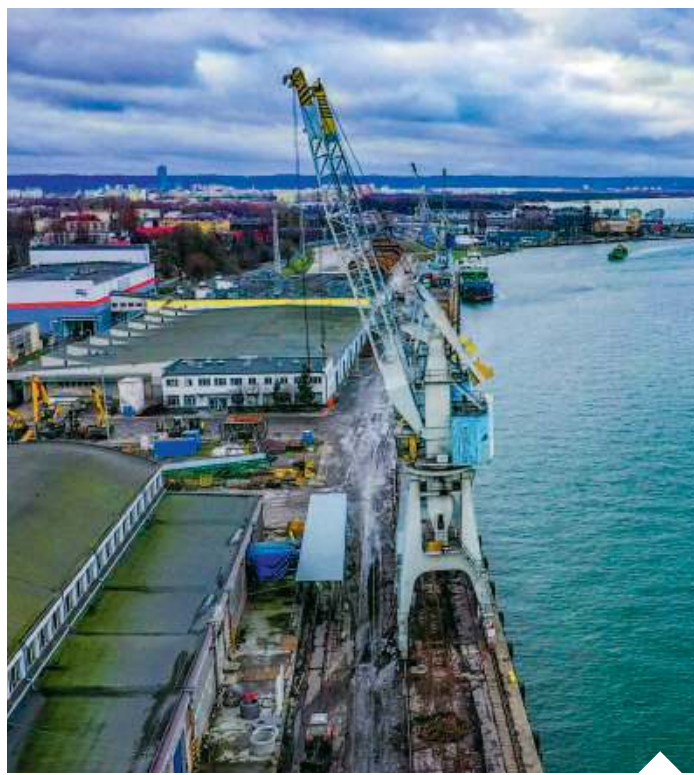
Łącznie na projekty dotyczące rozbudowy polskiej infrastruktury portowej pozyskano 6 mld zł z budżetu UE w latach 2014–2020 | fot. mat. pras./d
