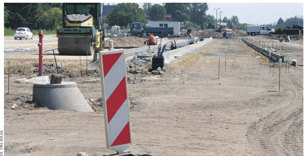
Prace za dworcem PKP w Krzeszowicach
