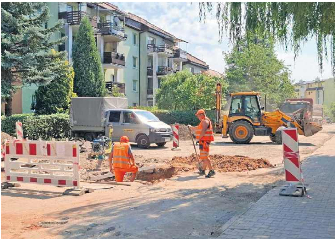
Na ulicy Wysockiego w Starachowicach rozpoczęły się prace związane z przebudową drogi.
