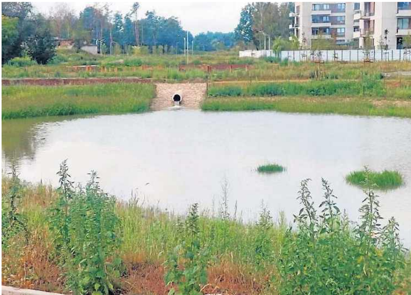
Budowa parku ze stawami na Wacynie w Radomiu stanęła. Wodociągi Miejskie przygotowują kolejny przetarg.
