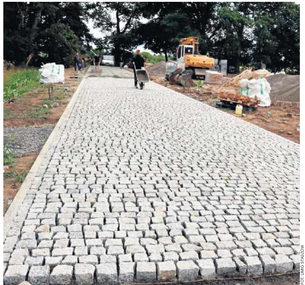
- Powstaje nowa droga dojazdowa oraz parking
