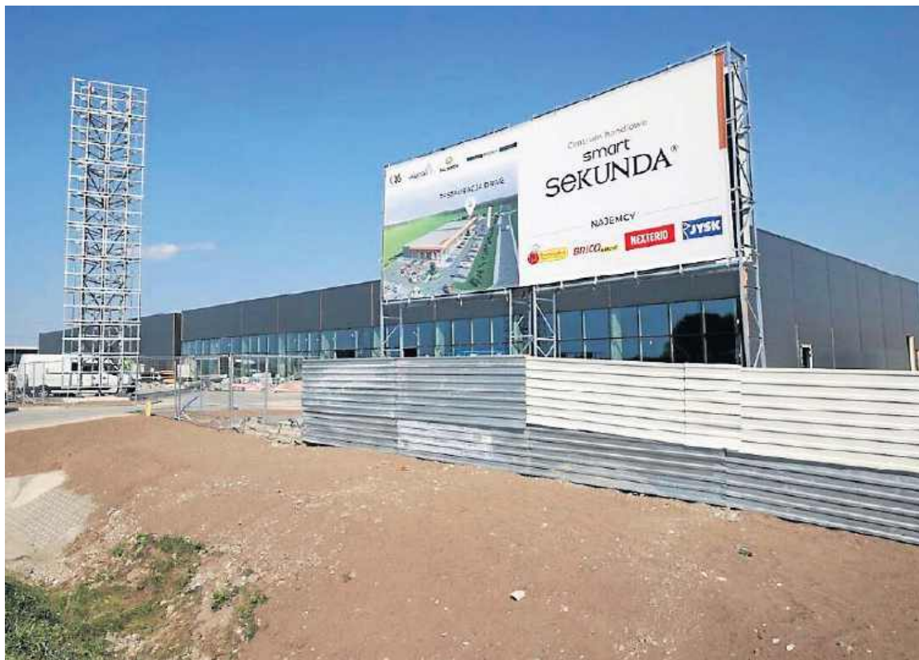
Po lipcowym otwarciu Galerii Sekunda we Włoszczowie nadchodzi nowe centrum - Smart Sekunda. Trwa budowa.
