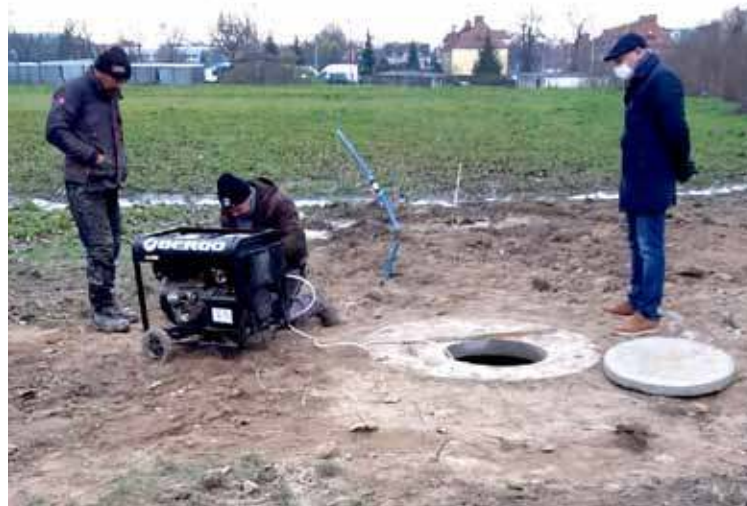
Ostatnio przy Ceglanej wywiercona została studnia
