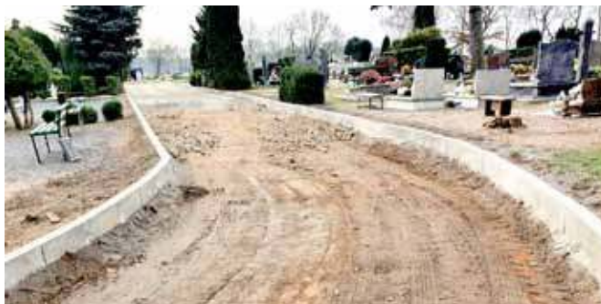
Prace prowadzone są na cmentarzu przy ulicy Kościuszki oraz w Kluczewie
