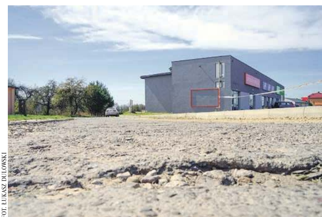
Spacerowa w Alwerni przed remontem
