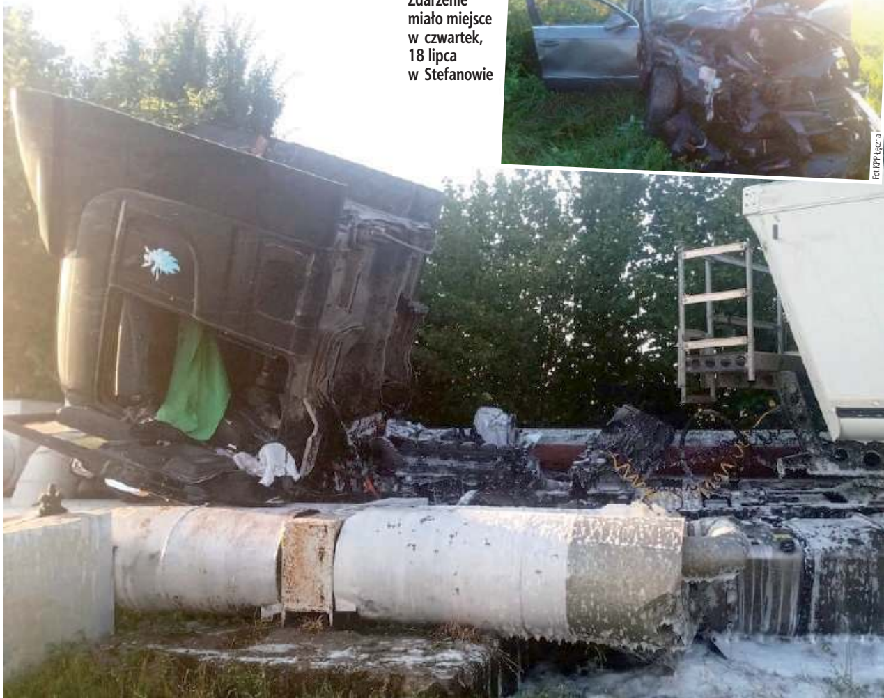
Ciężarówka wypadła z drogi i uderzyła w węzeł ciepłowniczy, uszkadzając go
