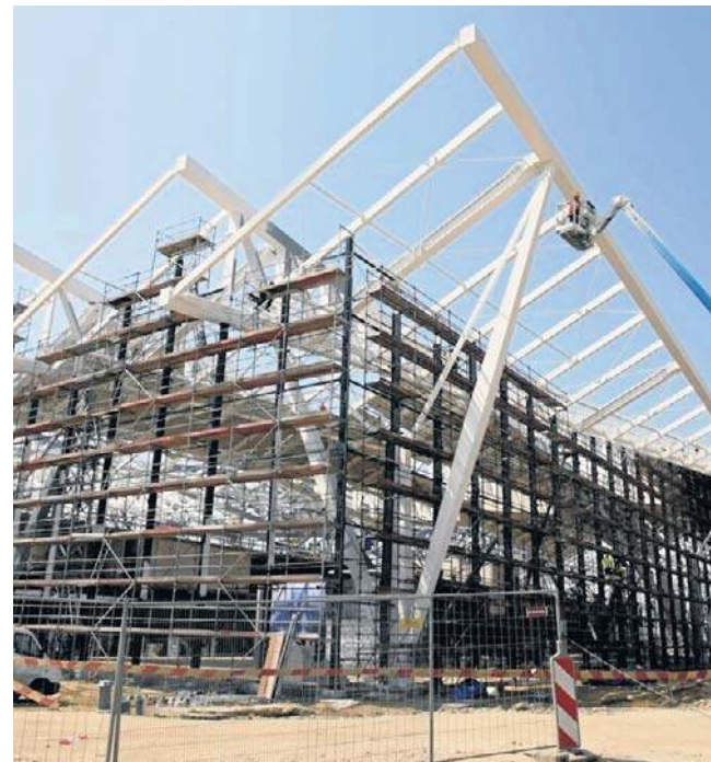
Tak przebiegała rozbudowa gdańskiego lotniska, które zyskało drugi terminal pasażerski
