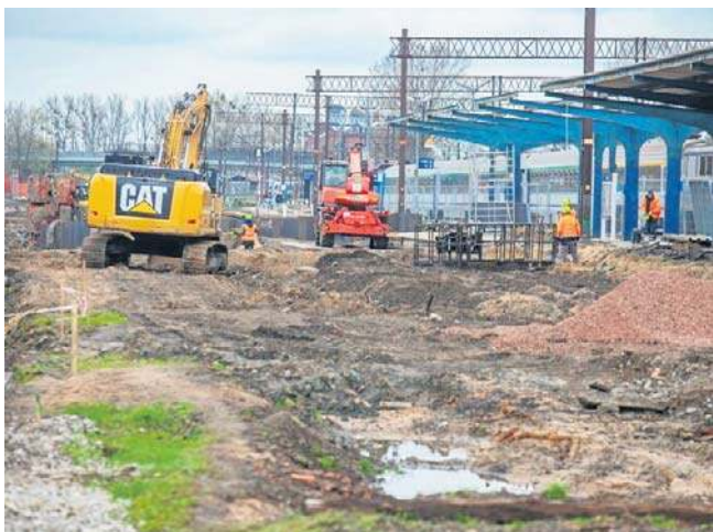
Poza wymianą torowisk, przebudowie peronów powstanie m.in. lokalne centrum sterowania
