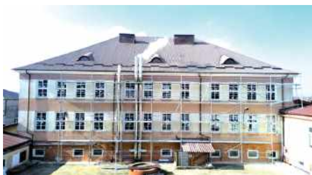
We Frampolu trwa remont budynku szkoły
