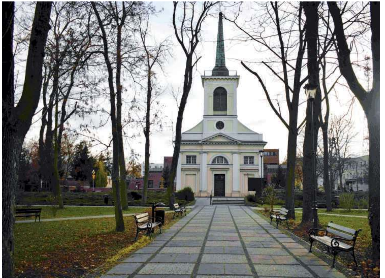
Remont w kościele pw. św. Michała Archaniola trwa już od 10 lat
